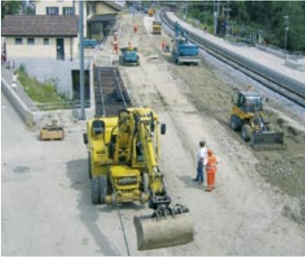
WEBER AG im Einsatz für die Unterbauerneuerung (Fundation und Schotter) im Bahnhof Aesch. Mitte Juli standen besonders intensive Wochenende auf dem Programm.
