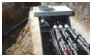
Dieser Werkleitungsbau wurde zu Beginn des Jahres am Salinenweglein ausgeführt.
