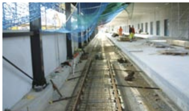
Trotz schwieriger und beengender Platzverhältnisse konnte der Gleisbau termingerecht fertiggestellt werden. Die Gleise mussten über Kopf gebaut werden.
