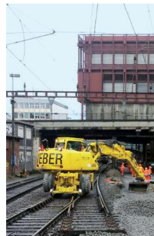
Die Arbeiten am Bahnhof SBB mussten unter zeitlichem Hochdruck und strengen Qualitätsvorgaben erfolgen.
