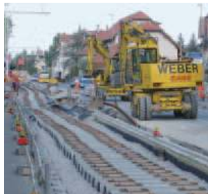
Neue Gleise in Aesch
