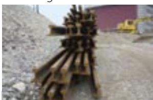
Die Schienen wurden vorgebogen, damit sie in der Richtung schöner, d.h. ohne Ecken, verlaufen.
