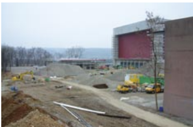
Zuerst musste der Werkleitungsbau abgeschlossen sein, danach konnten die Gleisarbeiten beginnen.
