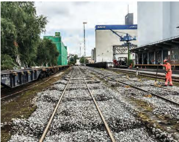
Einschottern mit Stopfen der Gleise.
