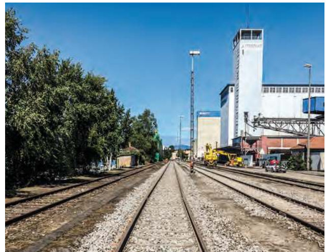
Die fertige Arbeit gewährleistet die geforderte Betriebssicherheit.
