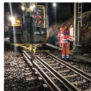
Nächtliche Arbeiten, damit der Verkehr bald wieder rollen kann.
