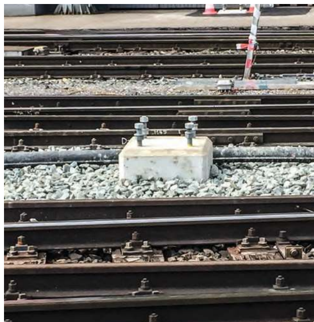
Das fertige Fundament, bereit für das Stellen des Mastes.
