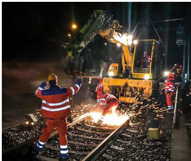
SBB-Hauptgleis in Lausen: Auswechseln einer schadhaften Schiene.
