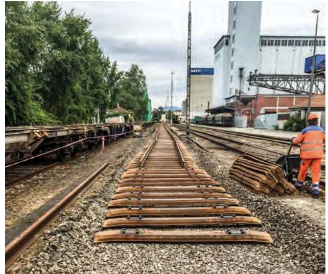
Das Hafen-Gleis wird neu verlegt.
