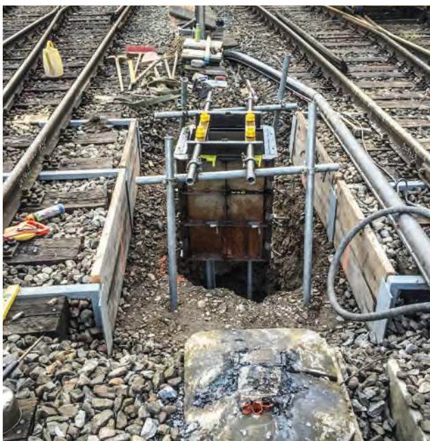
Aushubarbeiten für das Stellen des Mastes.
