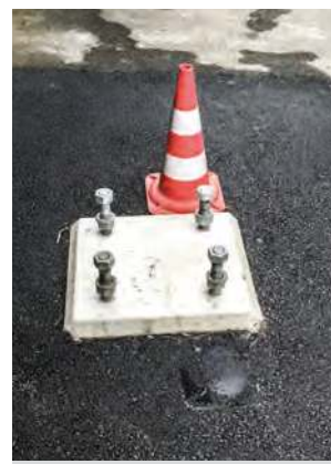
An den Schrauben wird der Mast befestigt.
