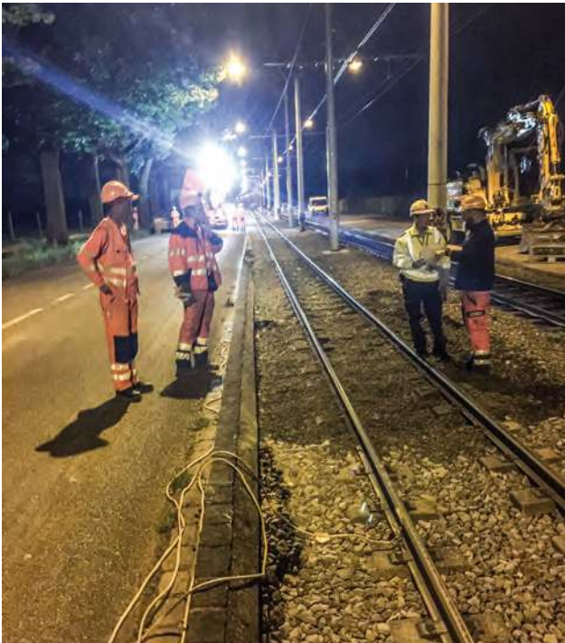
Äussere Baselstrasse in Riehen. Erneuerung schadhaftes Gleis für die BVB.
