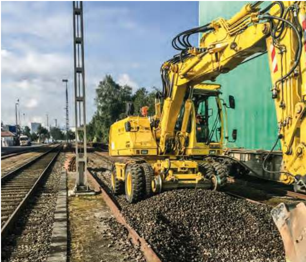
Maschinelle Aushubarbeiten inklusive Verdichtung des Unterbaus.
