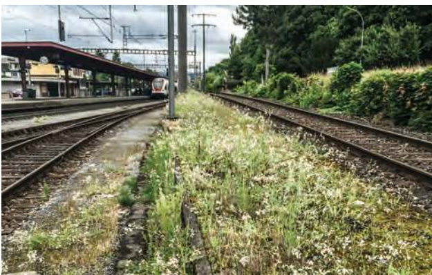
Wilde Vegetation entlang der Gleise erhöht die Unfallgefahr bei Gleiskontrollen.
