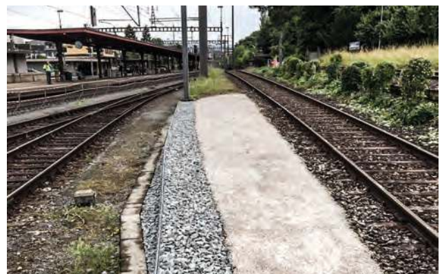
Saubere Bankette, sichere Kontrollgänge.
