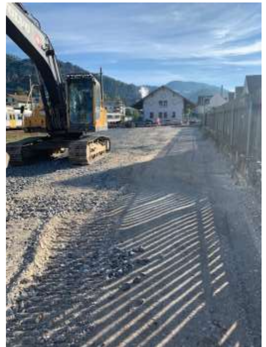
Abb 4 Installationsplatz Balsthal (Nachher)
