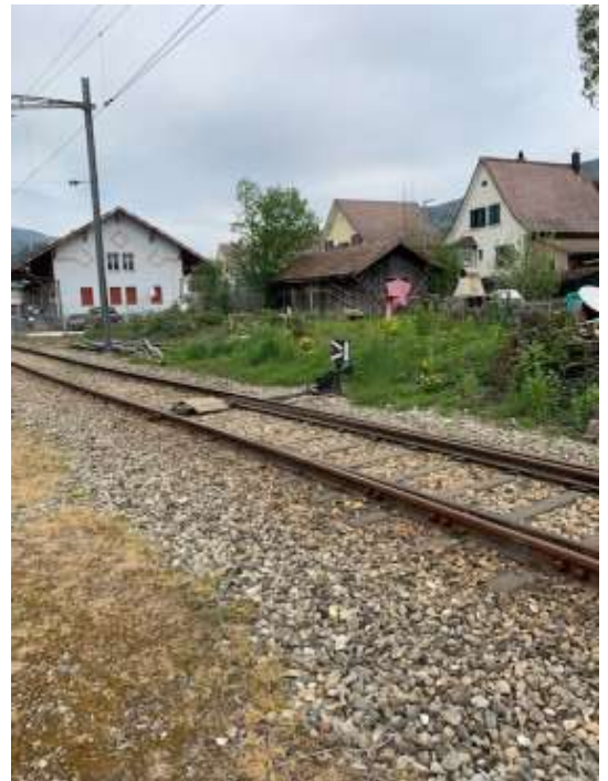
Abb 2 Installationsplatz Balsthal (Vorher)
