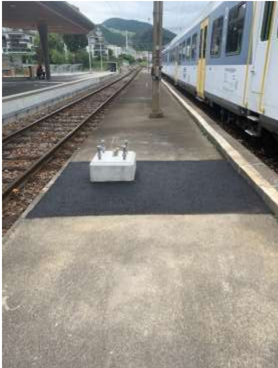
Abb 5 Perron 2/3 Balsthal (FL Mastfundamente)
