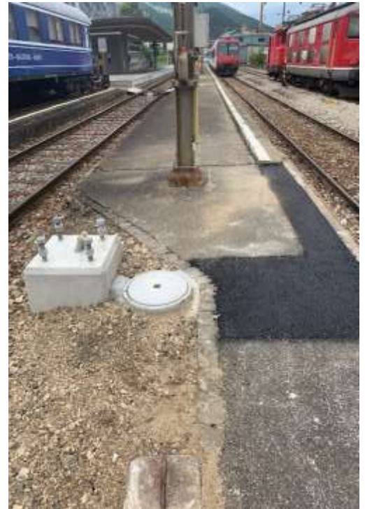
Abb 6 Perron 2/3 Balsthal (Kabelblock)
