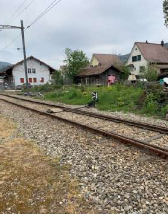
Abb 1 Installationsplatz Balsthal (Vorher)
