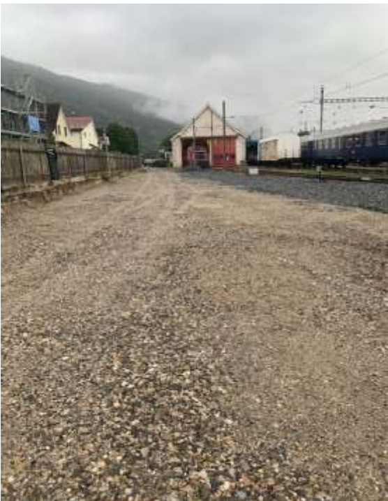
Abb 3 Installationsplatz Balsthal (Nachher)
